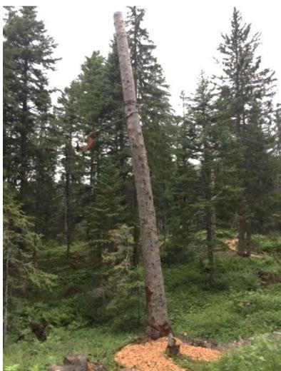
Lorsqu'aucun support n'est disponible à proximité de la ligne, un support incliné peut-être réalisé.
